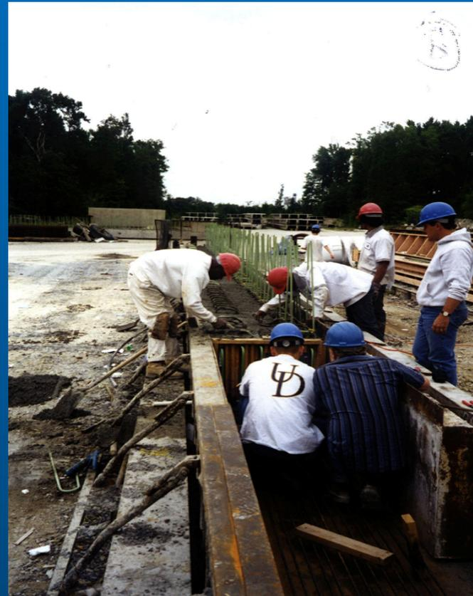
Einbau von CMS und TDR-Systeme in einen Brückenträger beim Highway 95 (von Philadelphia nach Boston)
